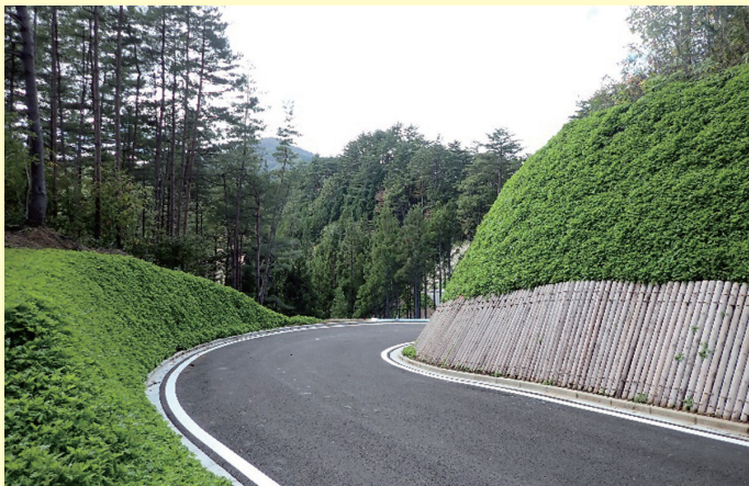
間伐材を活用した法面保護工が美しい景観を形成しています
