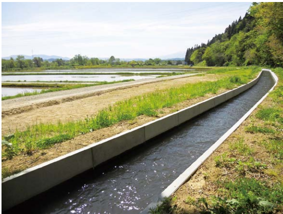
基幹水利施設ストックマネジメント事業 おうさかたいかんせんようすいろ 相坂平幹線用水路地区（十和田市）
