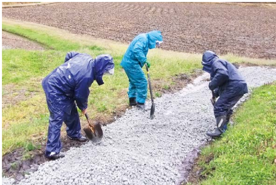
農道の簡易補修 にがら 荷軽井農事組合（五戸町）
