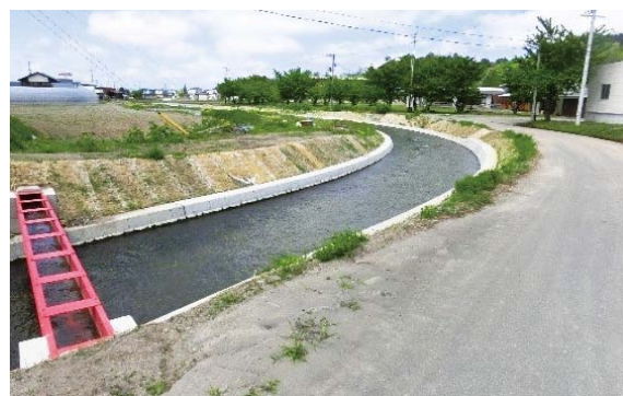
農業水利施設保全合理化事業 ひらかわだいいち 平川第一地区(弘前市、平川市他)
