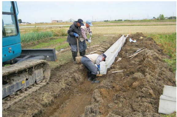
水路の更新 はらた 原田グリーンサークル（平川市）
