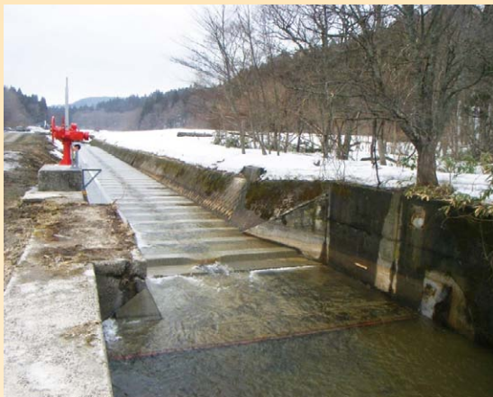
水路の整備 かみおぐに 上小国地区（外ヶ浜町）
