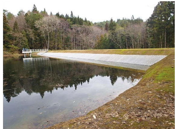
ため池等整備事業 しもおくに 下小国たかのご地区（外ヶ浜町）
