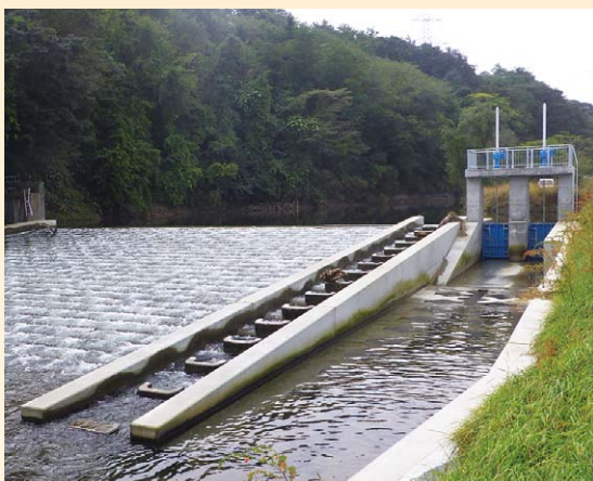
魚道の整備 かみかわら 上川原地区（三戸町）
