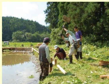
協議会による補修状況
