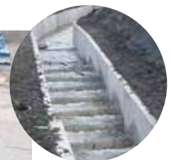
斜路式落差工
