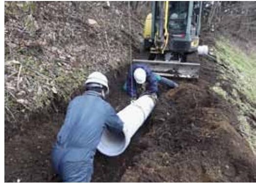
水路の改修 いづみ 泉地区資源保全会（三戸町）
