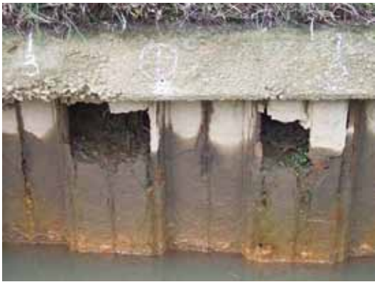
水路の老朽化
