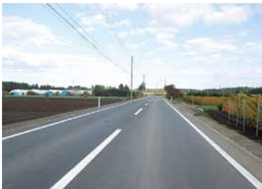
通作条件整備事業 このへほくぶ 五戸北部地区（五戸町）
