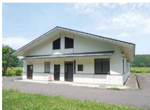
農業集落排水事業 石沢地区 (五戸町)
