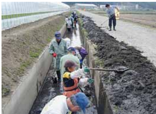
水路の泥上げ
