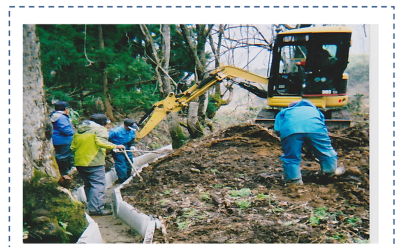
【U字溝設置作業】
