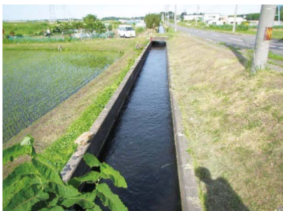
整備前 基幹水利施設ストックマネジメント事業
