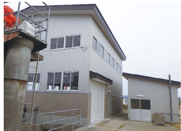
整備後 おだ がわなんぶ 小田川南部地区（五所川原市）
