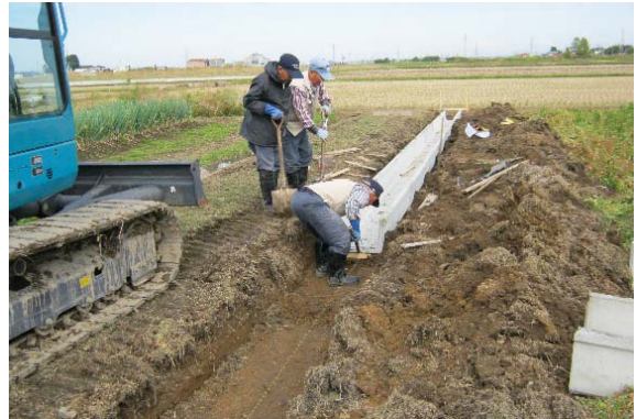
水路の更新 はらだ 原田グリーンサークル（平川市）
