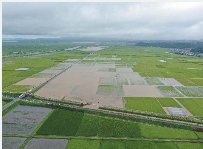
令和4年8月3日豪雨 中里川の堤防決壊による農地被害(中泊町)
