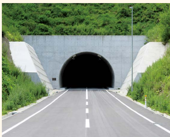
農道トンネルの整備 西海岸関地区（深浦町）
