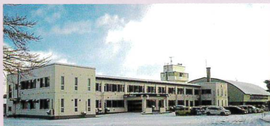
改修工事後の校舎
