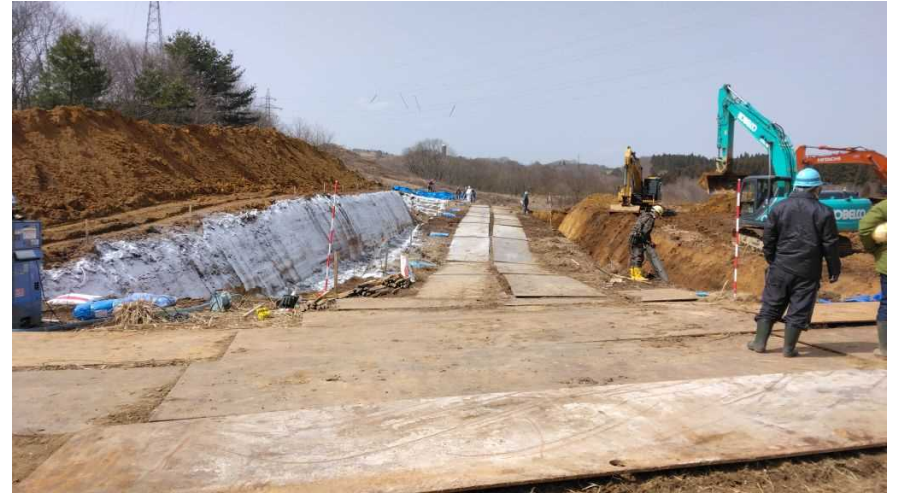
⑥2023. 03. 25 (11 時頃) 掘削作業の様子 2
