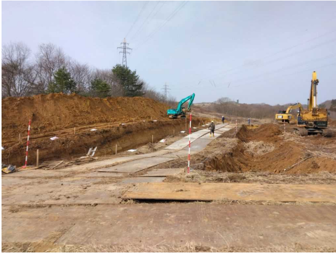
⑤2023. 03. 25 (9 時頃) 掘削作業の様子 1
