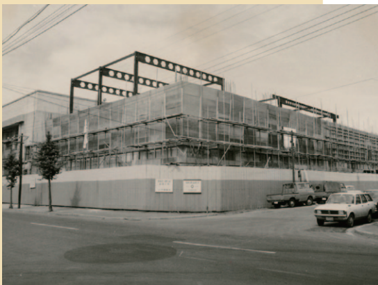
昭和46(1971)年 建築工事中の郷土館本館 正面側
