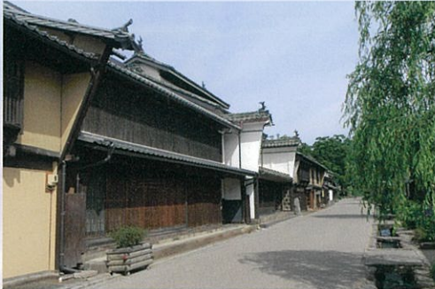
平成30年度採択団体：東御市（とうみし） 活動名：海野宿重要伝統的建造物群保存地区「伝統的建造物群等保存の記録Ⅲ」作成活動 助成額：302千円
