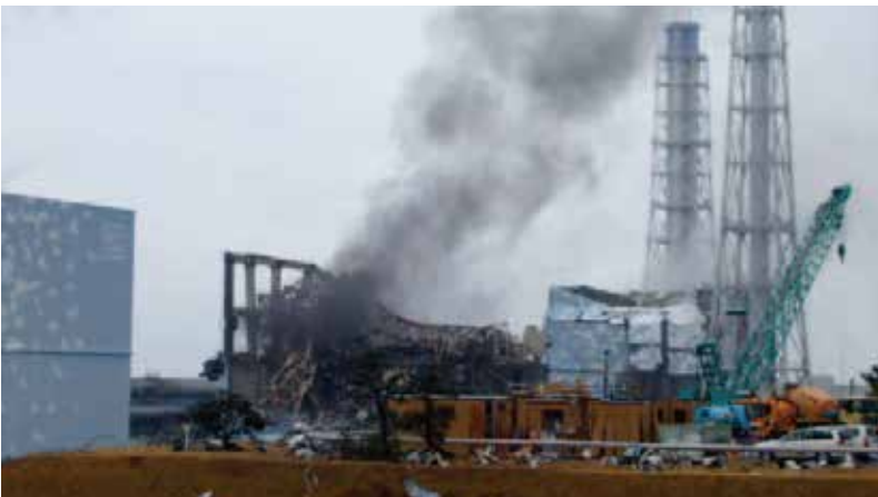
福島第一原子力発電所3号機 (出典:東京電力ホールディングス)
