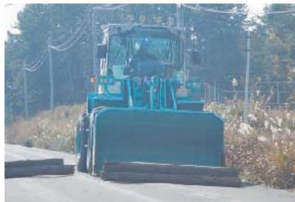
ホイールローダによるがれき撤去訓練
