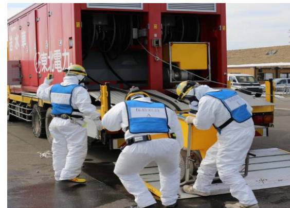
代替海水ポンプ設置訓練
