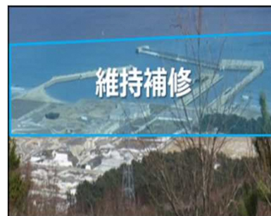
港湾設備の維持補修
