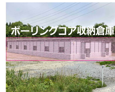
ボーリングコア収納 倉庫の増設
