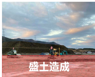
建設作業エリアの造成
