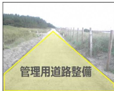
敷地周辺監視柵等を 管理するための道路を設置
