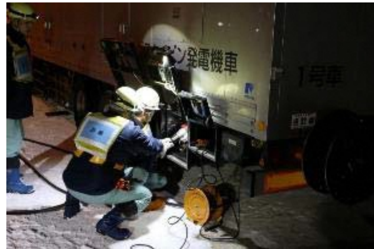
電源車へのケーブルの繋ぎこみ
