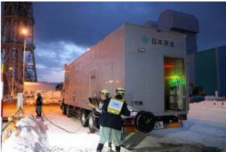
電源車から建屋にケーブルを敷設
