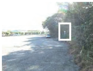
【写真 2】建物撤去 (H24. 9. 13 撮影) ・建物撤去および砕石敷設
