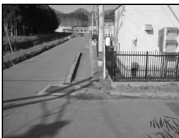
写真1 周辺環境変化前 (工事前:H23.11.1 撮影)
