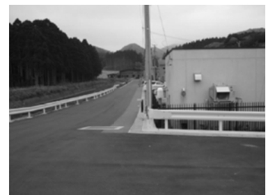
写真3 周辺環境変化後 (工事後:H24.5.21 撮影)
