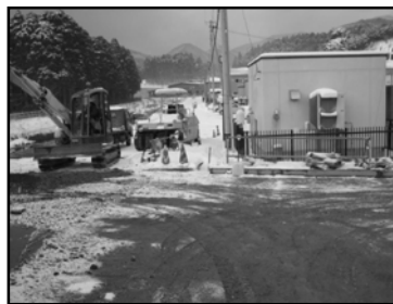
写真2 周辺環境変化後 (工事中:H23.12.19 撮影)
