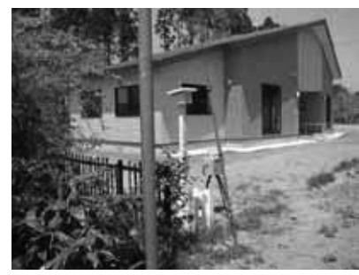
写真3 新測定場所・工事後 平成23年5月26日撮影
