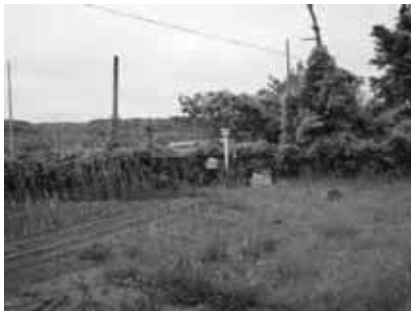
写真1 旧測定場所・工事前 平成22年6月11日撮影
