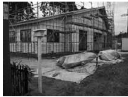
写真2 新測定場所・工事中 平成22年12月22日撮影
