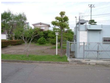
写真 1 : 周辺環境変化前 (工事前: H20.9.25 撮影)
