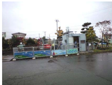
写真 2 : 周辺環境変化後 (工事中: H21.11.10 撮影)
