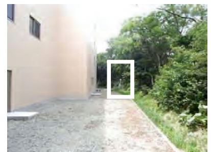
【写真 3】工事完了後 (H26. 7. 7 撮影) ・建物完成
