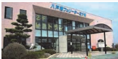
復旧後のフェリーターミナル
