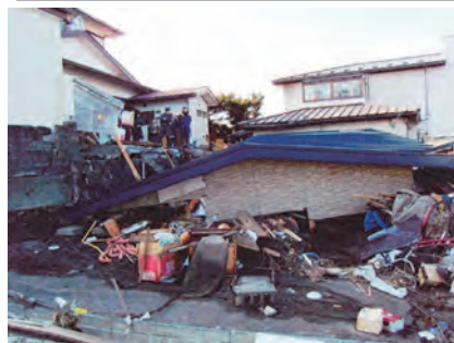
倒壊した住宅
