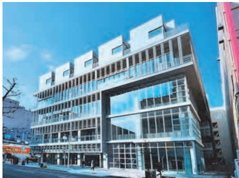
5階建てで夏季には壁面が緑化される
