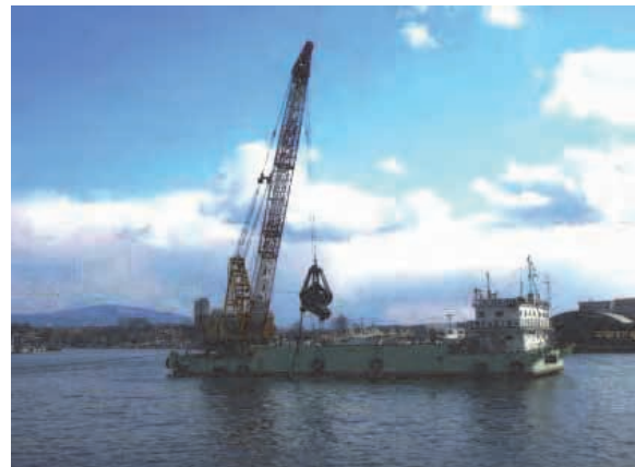
海底支障物の撤去
