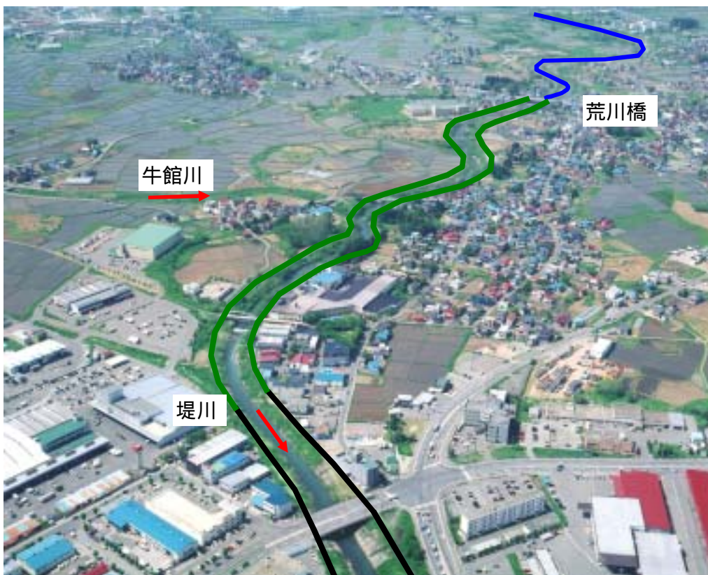
現況写真 (未改修区間)
