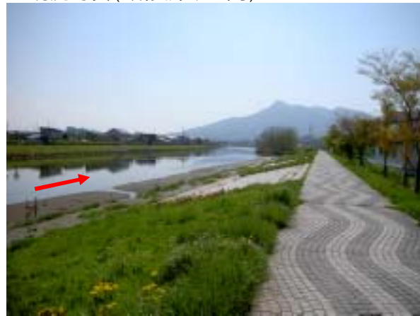
現況写真(改修済み区間)
