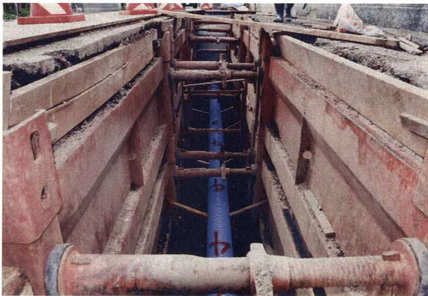
本管布設状況
