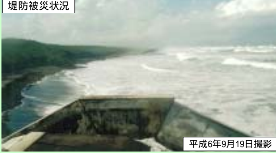
堤防被災状況
