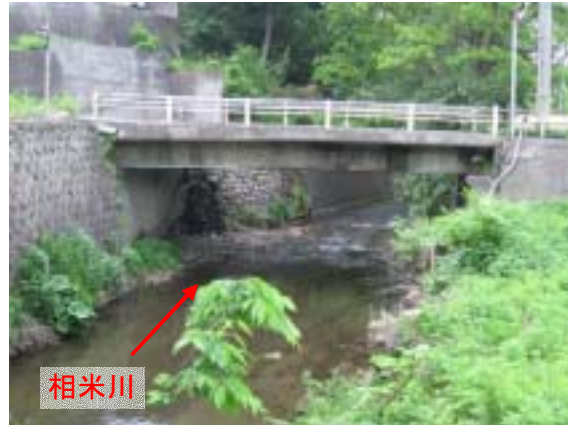
現況写真(稲守橋付近)
