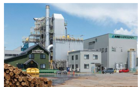
平川市にある発電所
