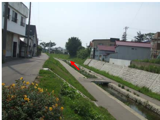
②現況写真(改修済み区間)
