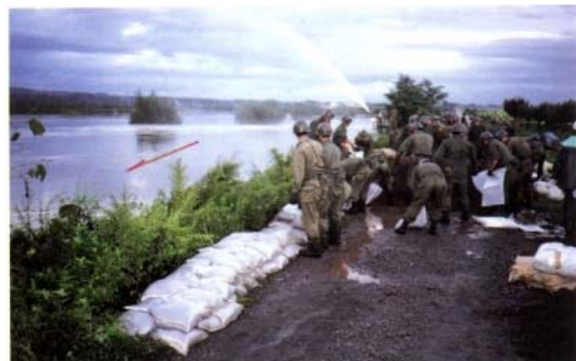
③浸水被害状況(平成2年9月)
