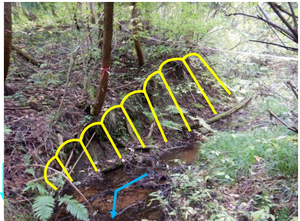
上流溪流の状況(斜面崩壊)
