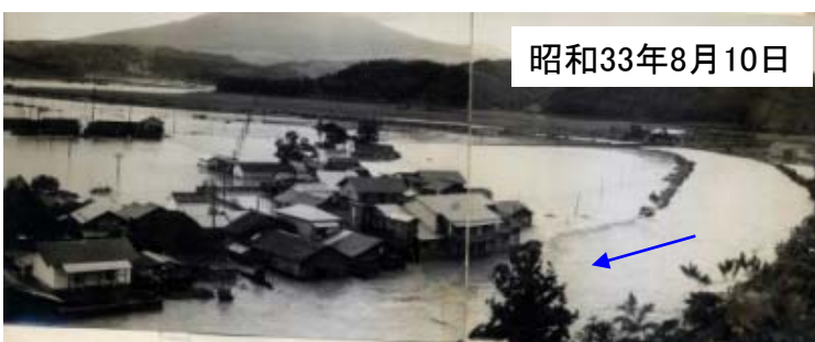
③出水時の状況
