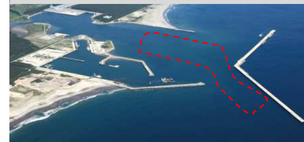
航路・泊地の浚渫 【むつ小川原港】
