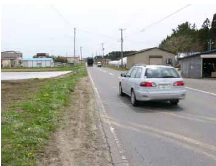
堆雪幅未確保
