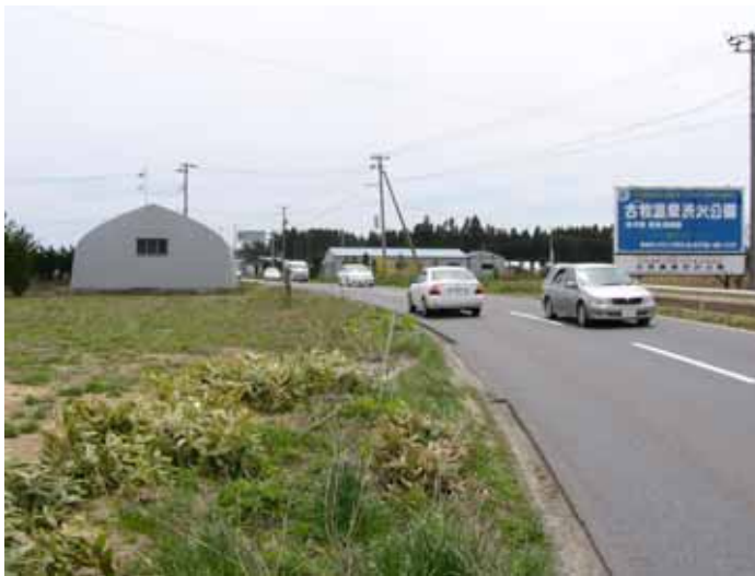
堆雪幅未確保
