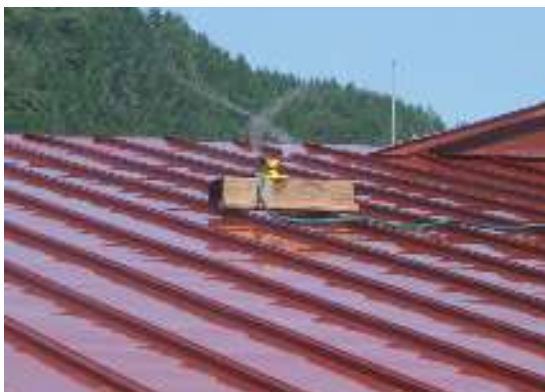
屋根への散水
