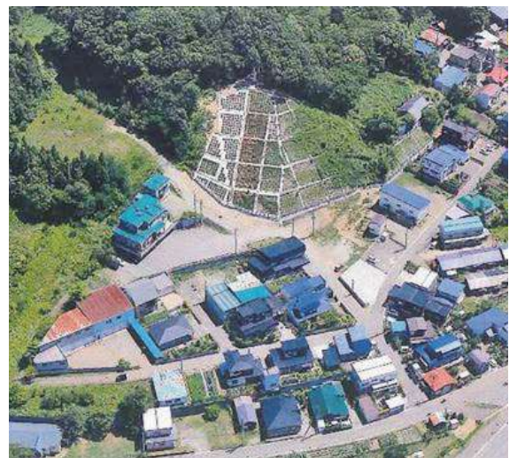
船橋区域急傾斜地崩壊対策事業（野辺地町）
