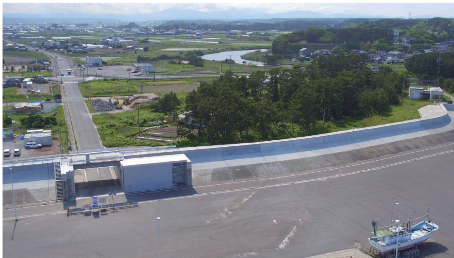
(写真:奥入瀬川地震・高潮 対策河川事業)
