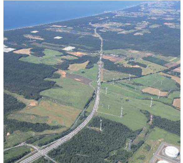
国道279号下北半島縦貫道路吹越バイパス全景
