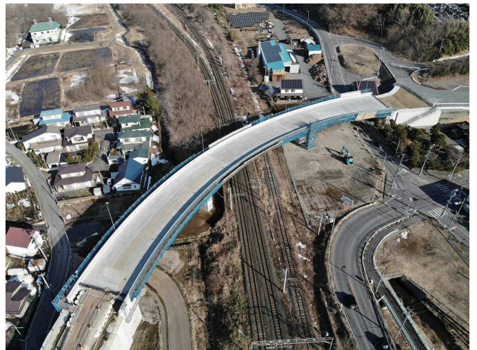
三沢十和田線（古間木橋）工事（三沢）
