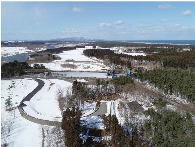
国道338号（高瀬川第2橋）工事（三沢市）
