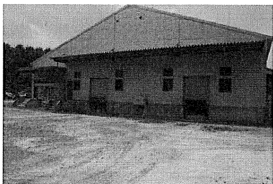
写真1 養鶏場事務所兼GPセンター
