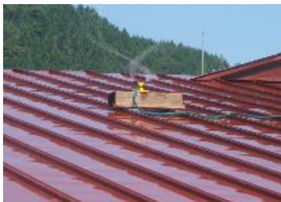
屋根への散水
