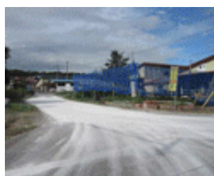
消石灰帯の設置による車両消毒
