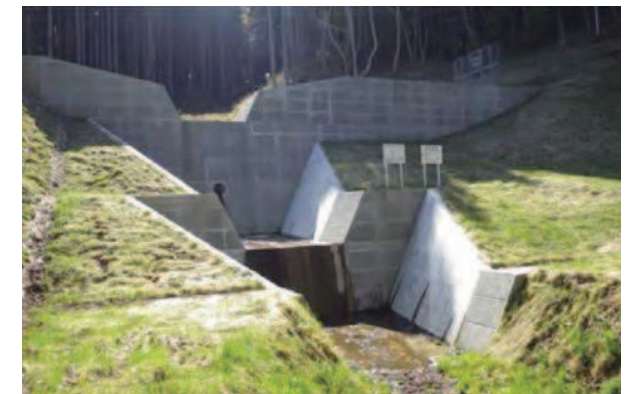
蛇浦川通常砂防事業・2号堰堤
