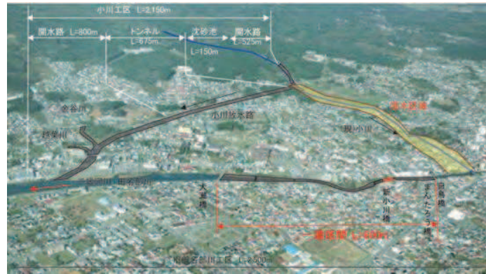
田名部川広域河川改修事業(H29 概成)
