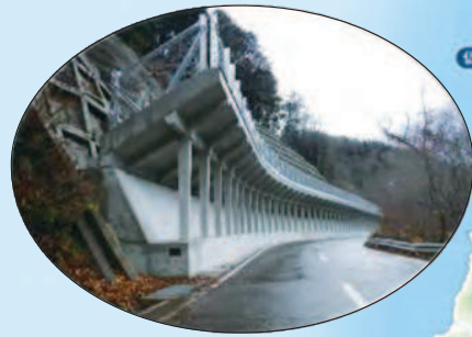
川内佐井線道路改良事業 スノーキーパー設置
