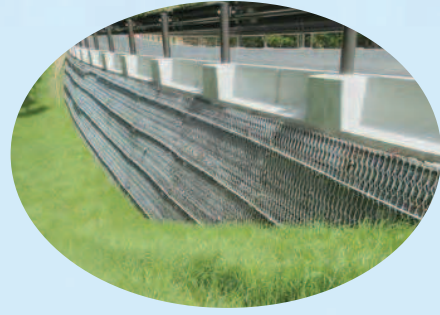
薬研佐井線道路改良事業(補強土壁工)
