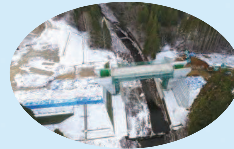
古野・大川目線(県代行)事業 橋梁上部工施工状況
