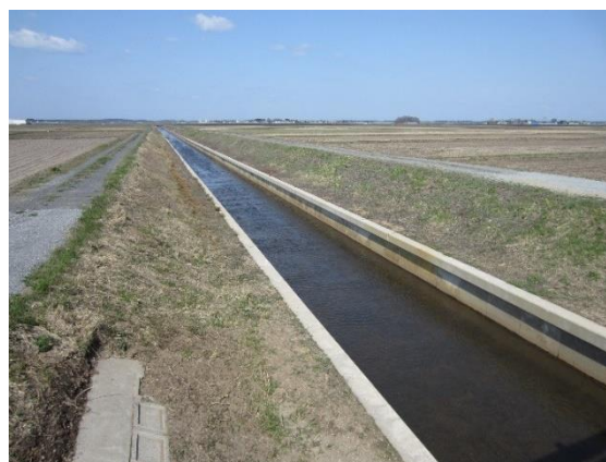
県営岩木川左岸 3 期地区かんがい排水事業により整備を行った水路
