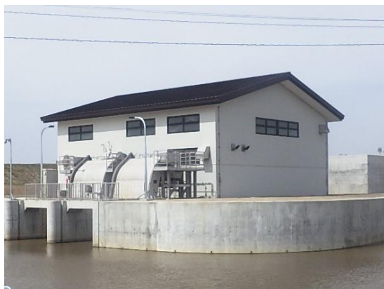
県営小田川南部地区農業水利施設保全合理化事業により整備を行っている森内排水機場
