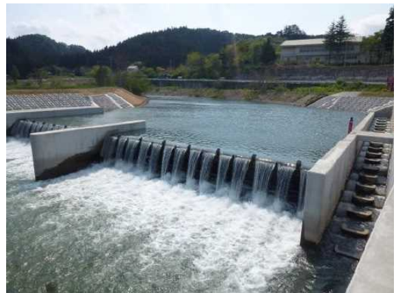
農業用河川工作物応急対策事業 (鱒ヶ沢堰地区、鱒ヶ沢町 H26～H30)
