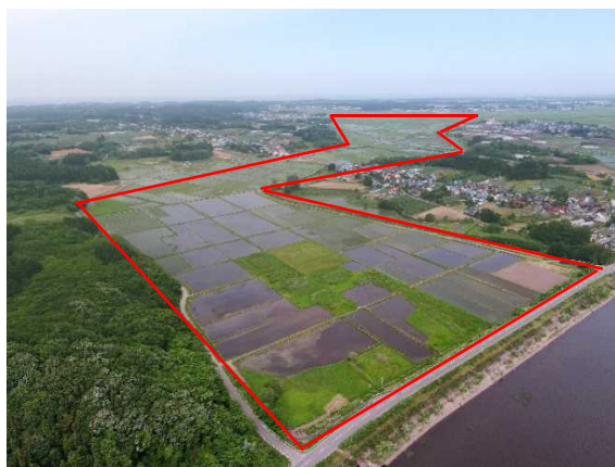
経営体育成基盤整備事業 (狄ヶ館地区、つがる市 R3~R8) 区画整理工
