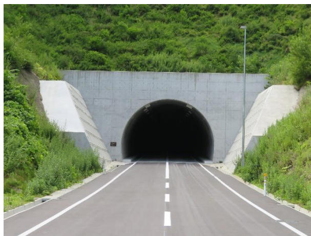
西海岸地区で整備した県内初の農道トンネル (亀杉トンネル)
