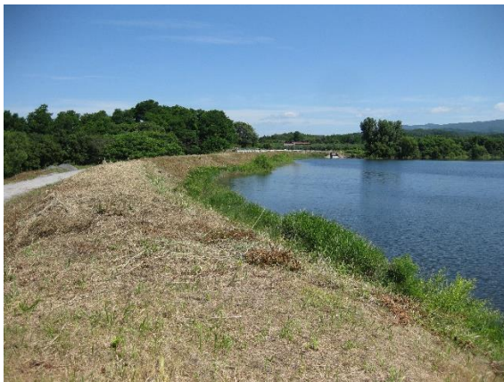
ため池等整備事業 (高野大溜池地区、五所川原市 R1～R3)
