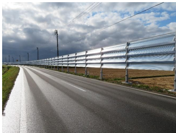
通作条件整備事業 (五所川原地区、五所川原市 R1~R5) 防雪柵工
