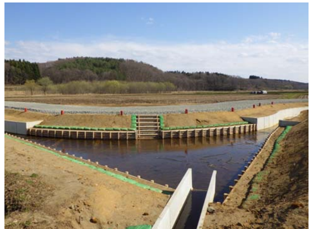
農用排：切佐坂（環境配慮型水路）
