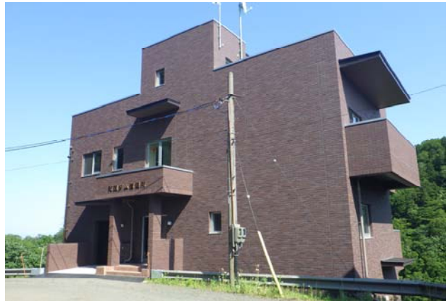
天間ダム管理所
