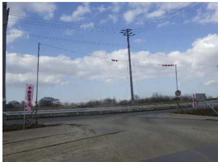
藤崎橋現場出入口
