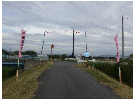
高さ制限簡易ゲート設置状況 藤崎橋(伐採時)現場出入口
