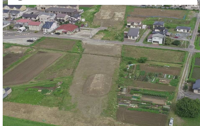
③尻内側堤防背後地(地盤改良)
