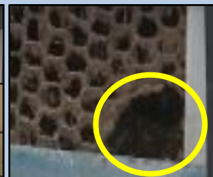
金網等の破損箇所修繕
