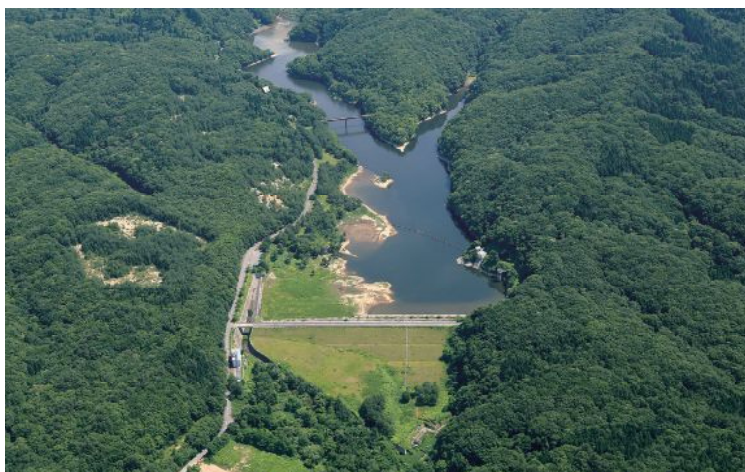
飯詰ダム（五所川原市）
