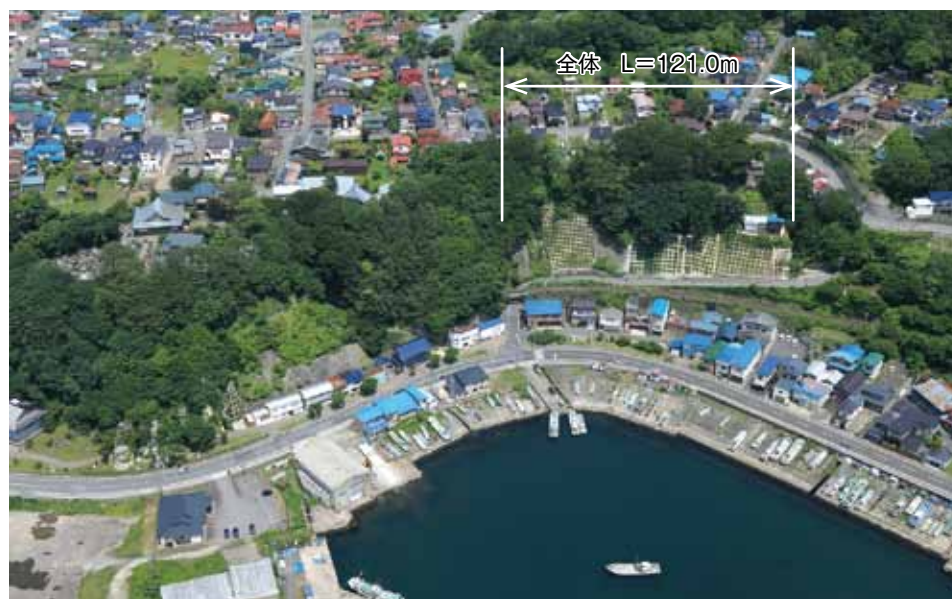
万年坂区域急傾斜地崩壊対策事業(深浦町)
