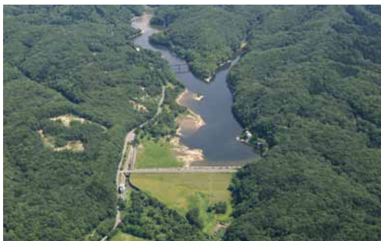
飯詰ダム (五所川原市)
