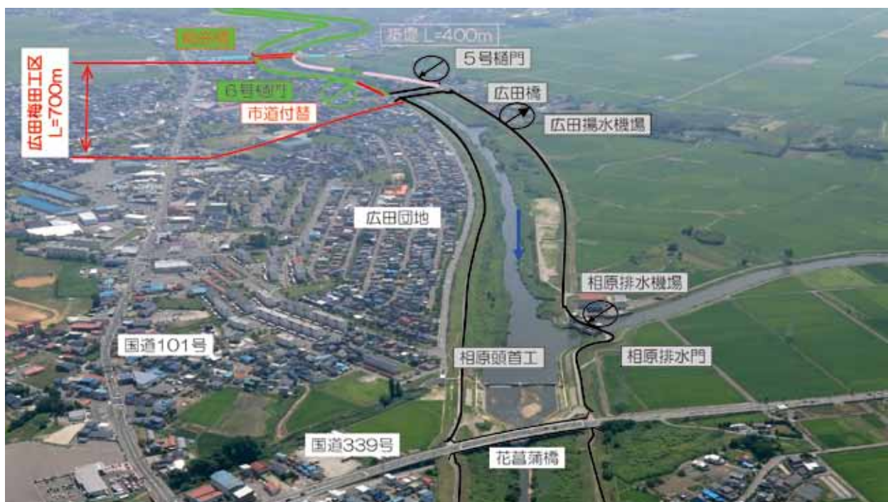
十川広域河川改修事業（五所川原市）
