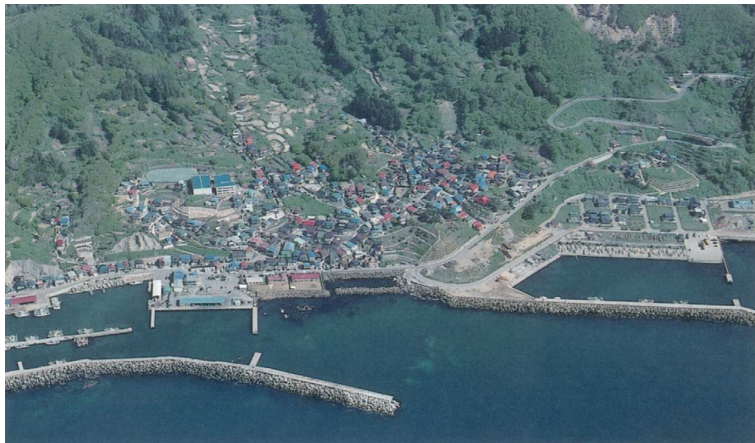
下前地区 情報基盤緊急整備事業 平成23年度完成（中泊町）
