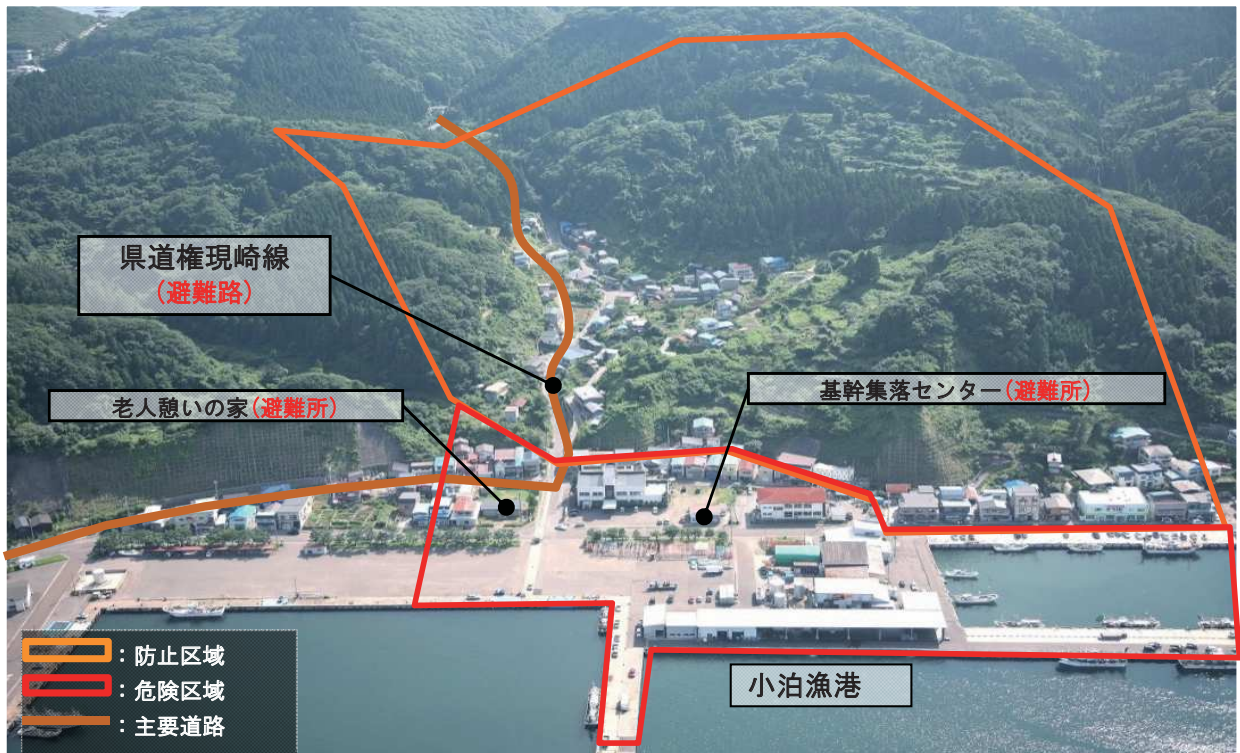
大山長根区域総流防地すべり対策事業（中泊町）
