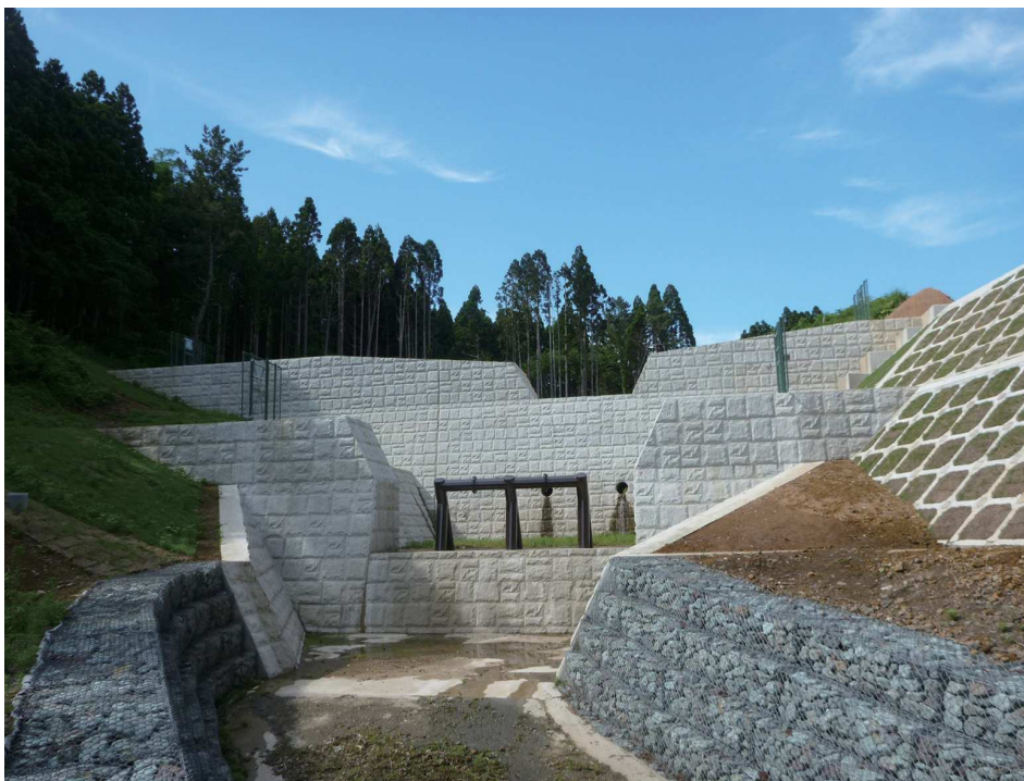
平成25年完成 吉花沢2号堰堤(深浦町)
